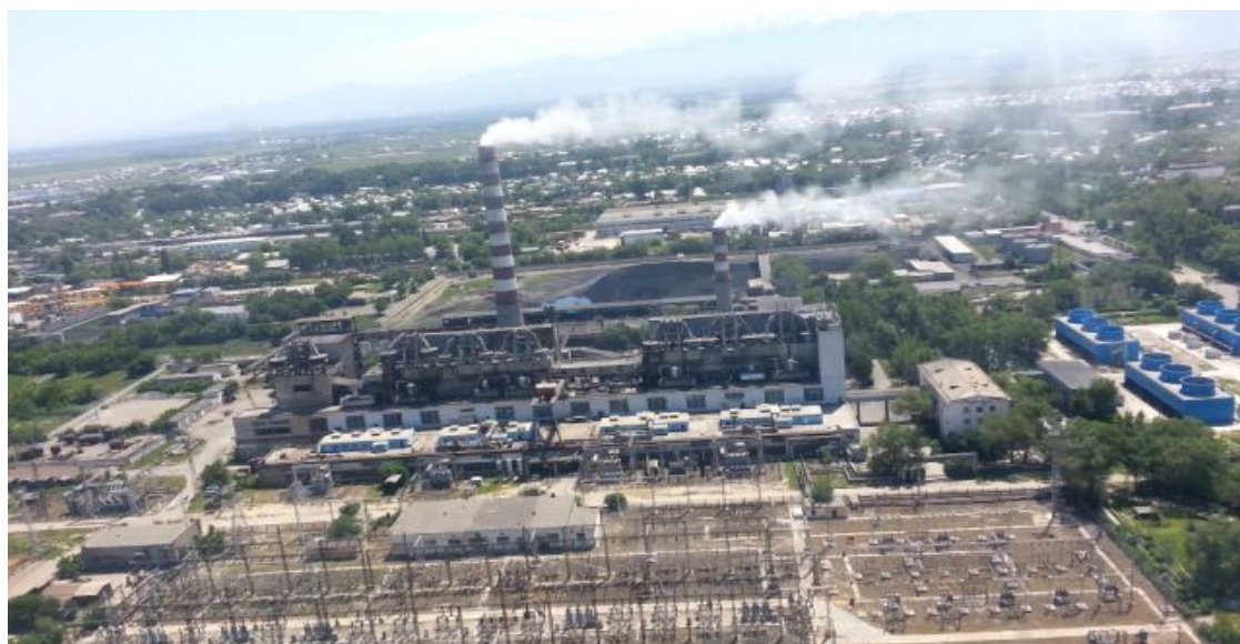
Рис. 2: Центральная часть АО «Алматинская Электрическая Станция ТЭЦ-3».
