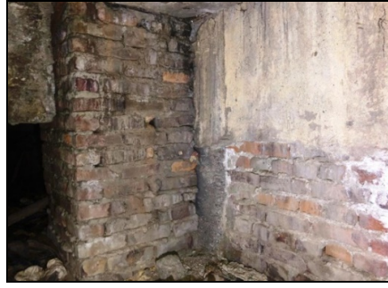
Şekil 30. Site Sineması Salon 6 üzerindeki kiriş kolon arasına baca konulmasıyla oluşan strüktürel düzensizlik
