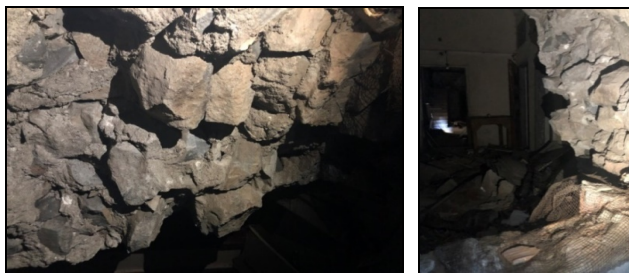
Şekil 11. Dilan Sinemasında bodrum kat duvarlarında kullanılan bazalt taş malzemesi
