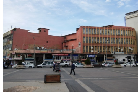
Şekil 3. Dilan-Site Sineması güneydoğu cephesi (2020)
