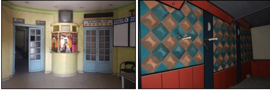
Şekil 12. Dilan Sinemasında alçı malzemenin kullanıldığı tavan ve duvar kaplamaları
