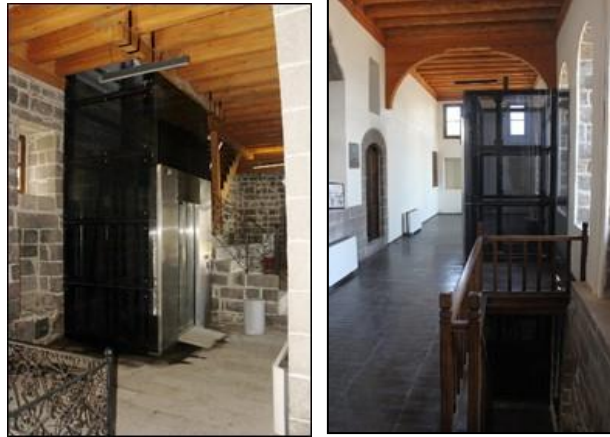
Şekil 7. Engelli ziyaretçiler için selamlık bölümüne yapılan asansör
